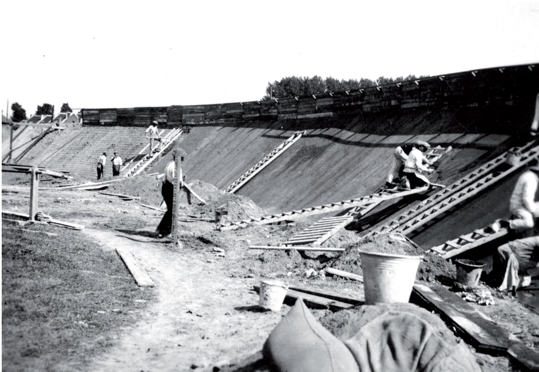
Werken aan de betonnen wielerpiste van het Leuvense sportpark, jaren 1930
