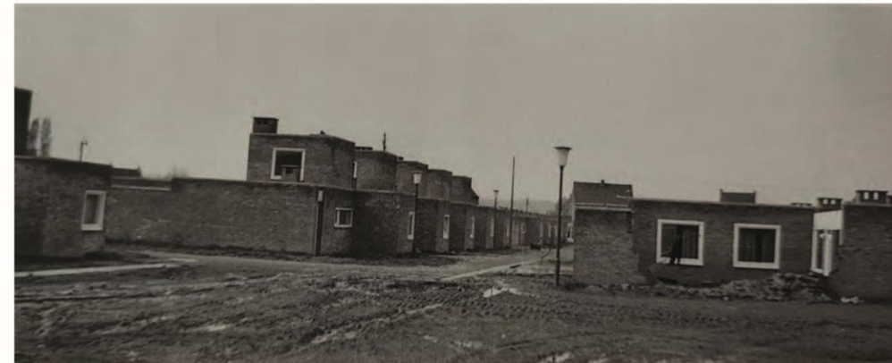
Fig 107: Construction of Den Elst ca. 1966.
