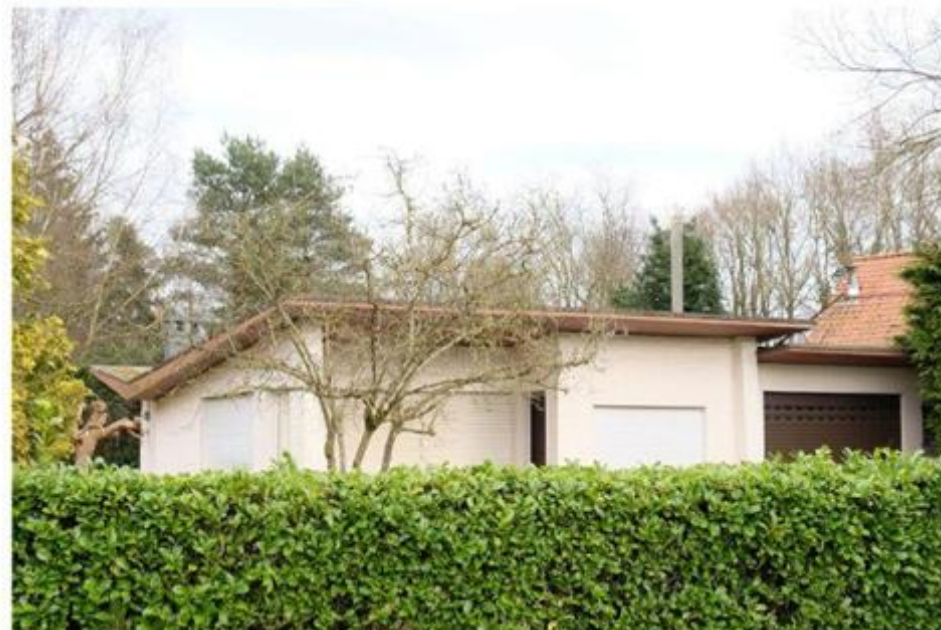
Vakantiewoning Grillet arch. Guillaume Vandenbranden 1957
