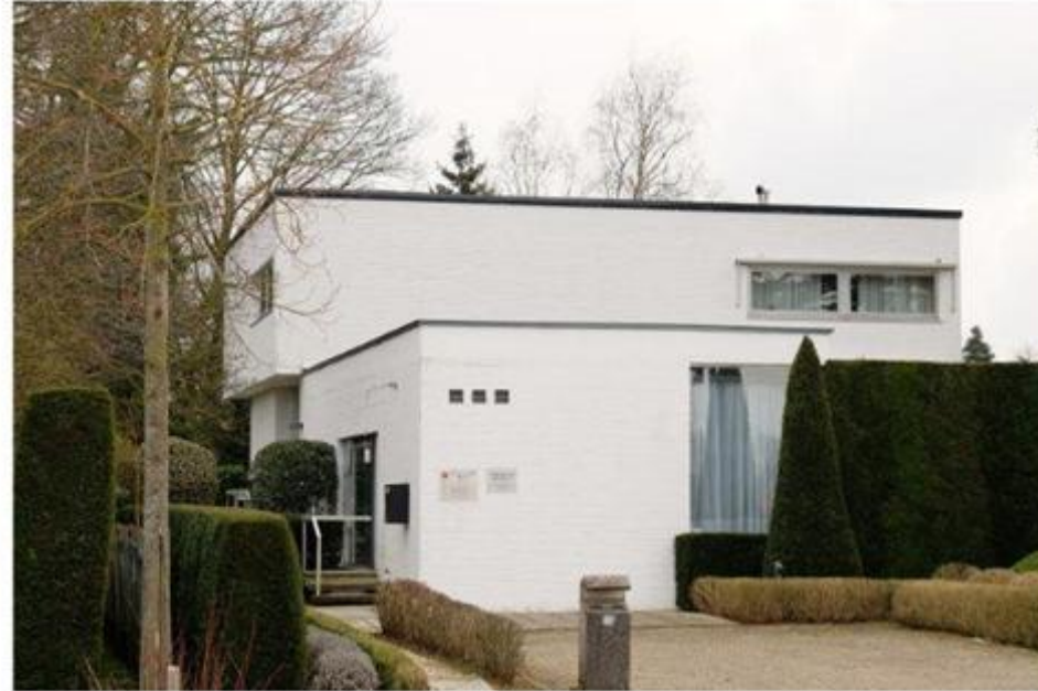
Woning Bessems arch. Roger De Winter 1966
