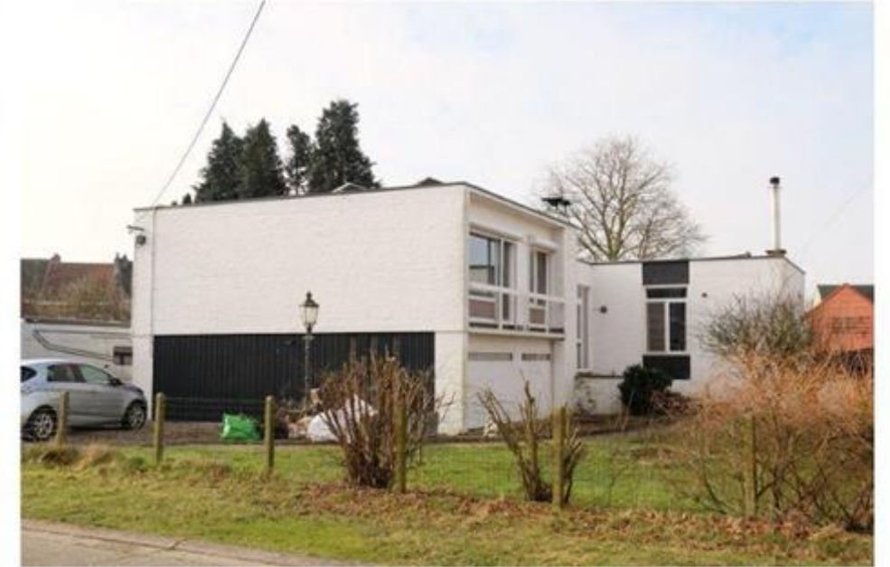
Woning Van De Vliet arch. Jan Levrier 1963
