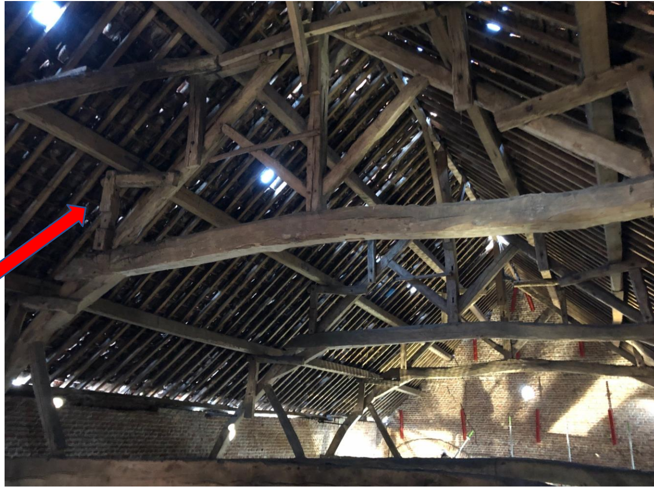
Bestaande dakspanten met trapsgewijze verhoging
