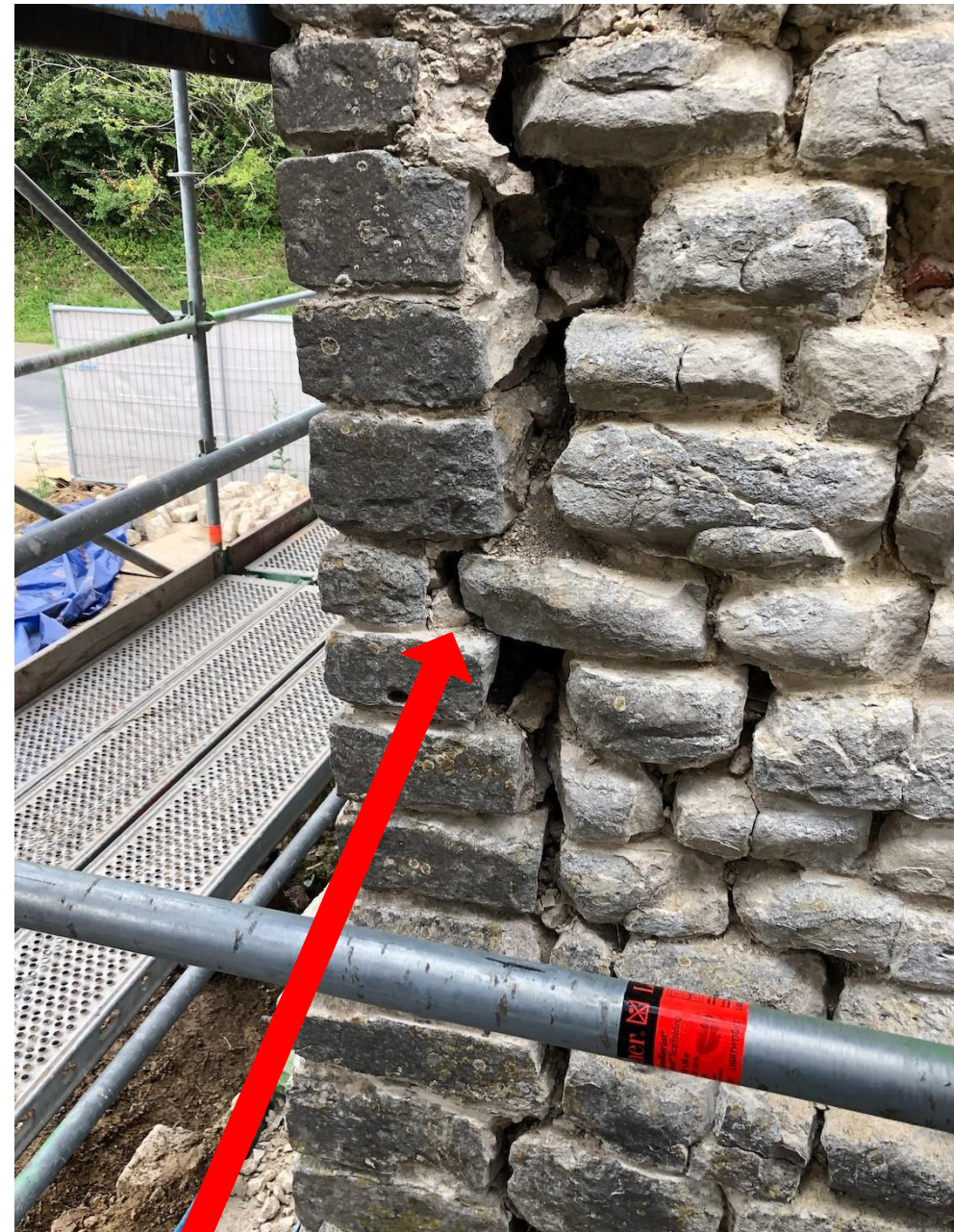
Herstelling van noordwand aansluitend op westelijke wand (thv spiltrap)
