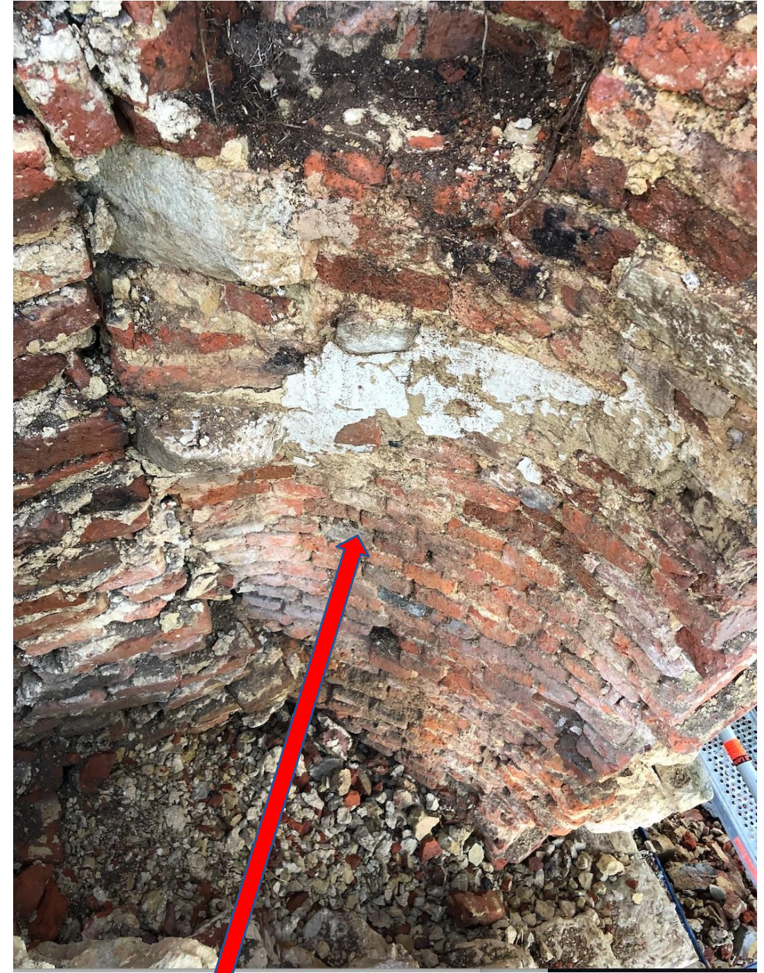
De ronding van de spiltrap met enkele resten Van de uitgebroken treden in de wand
