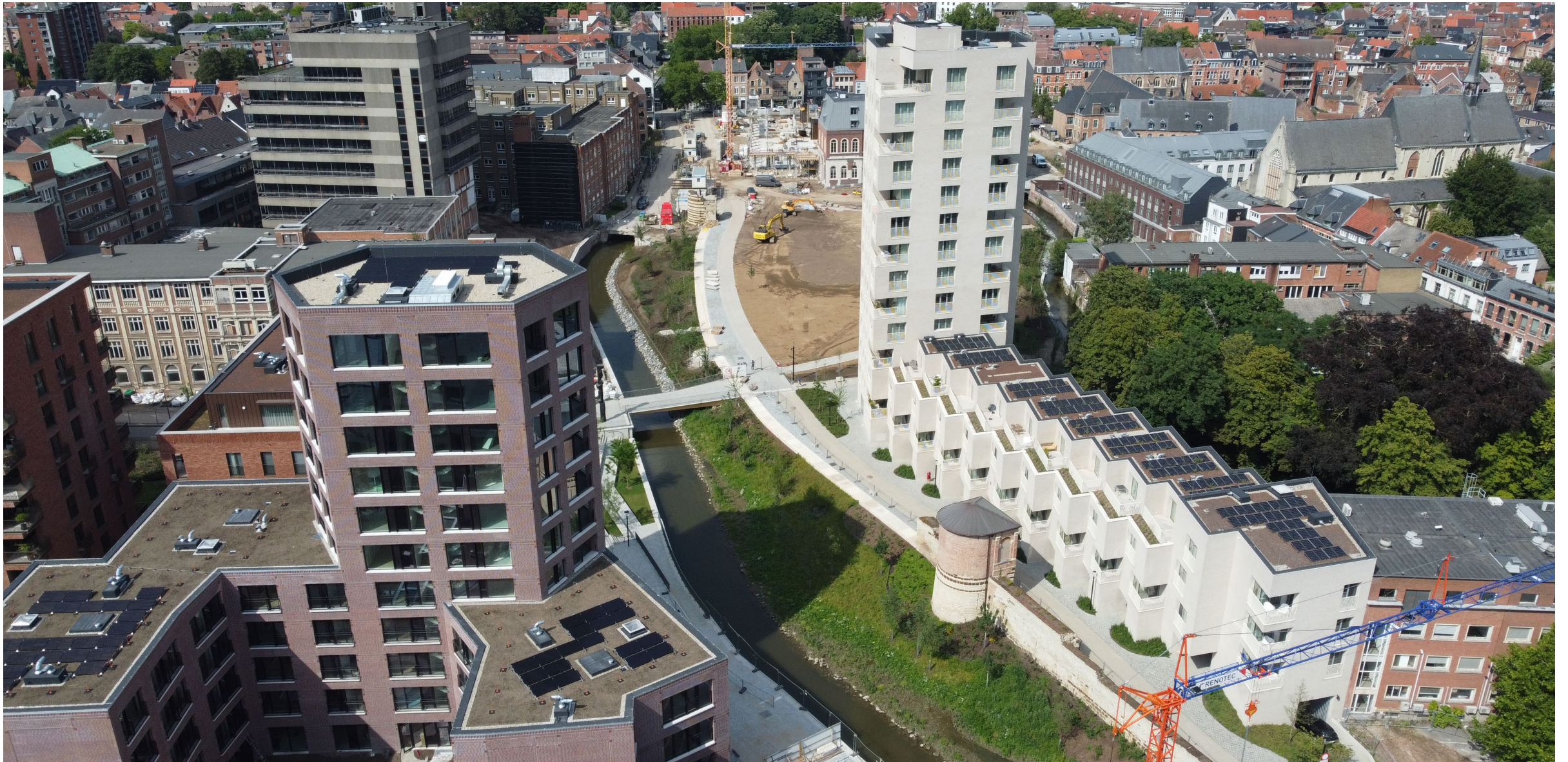
Dijle deels opengelegd
