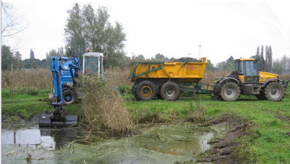
Foto 8. Voorzichtig baggeren van een poel om verstoring te beperken (Bron: Econnection)
