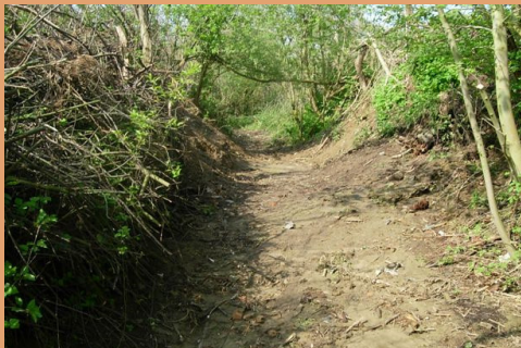
Foto 5. De bodem van de holle weg wordt langzaam maar zeker uitgeschuurd door een erosieproces in de langrichting van de holle weg (Bron: Regionaal Landschap Noord-Hageland)
