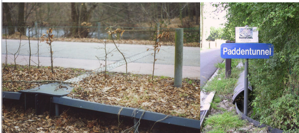
Foto 13. Amfibieënvoorziening onder de weg (Bron: Econnection)
