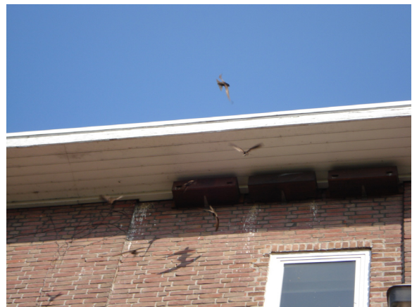
Foto: Voorbeeld van een groep nestkasten voor Gierzwaluw onder een dak. (Bron: Wim Debock)
