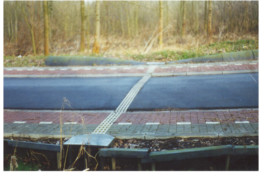
Foto: Amfibieëntunnel met geleidingswand (systeem Aco) te Oud-Heverlee. (foto Econnection)
