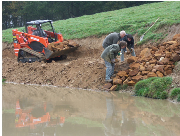
Aanleggen van een steenhoop die kan fungeren als schuilplaats en waarbij oeverbetredig door vee kan worden vermeden (Bron: Regionaal Landschap Dijleland).
