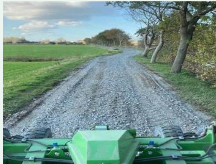
In-situ verwerking van betonplaten tot bitumineuze halfverharding: 20-40 euro/m 2
