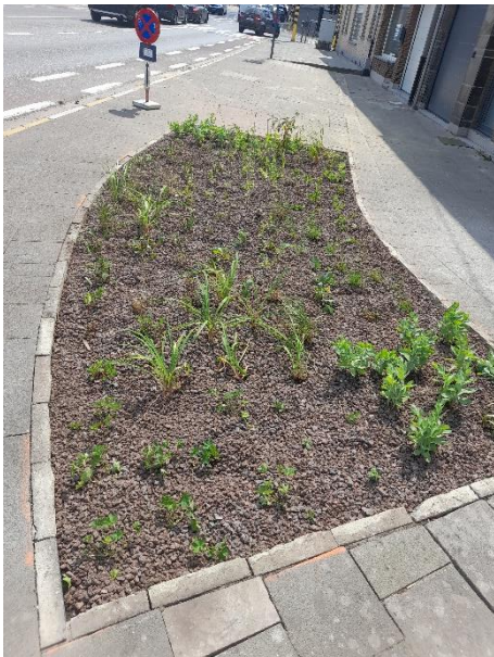
Figuur 6 Hergebruik tegels (op hun kant) als afboording Liedekerke
