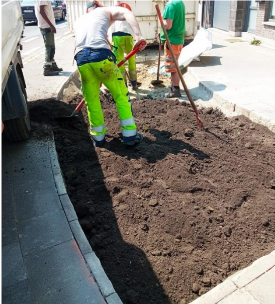
Figuur 5 Hergebruik tegels (op hun kant) als afboording Liedekerke
