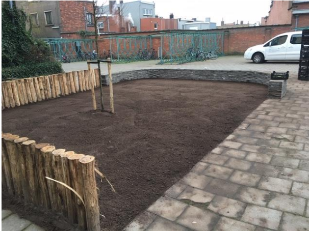
Figuur 7 Hergebruik tegels in stapelmuurtje
