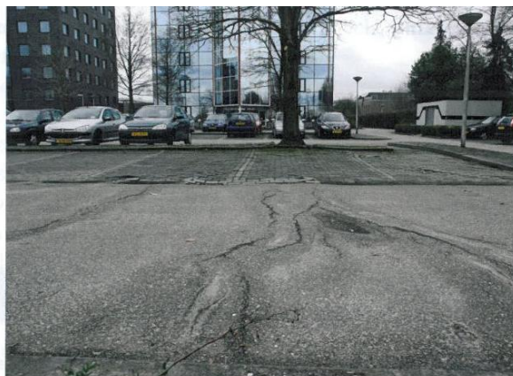
Wortelgroei vlak onder de asfaltlaag
