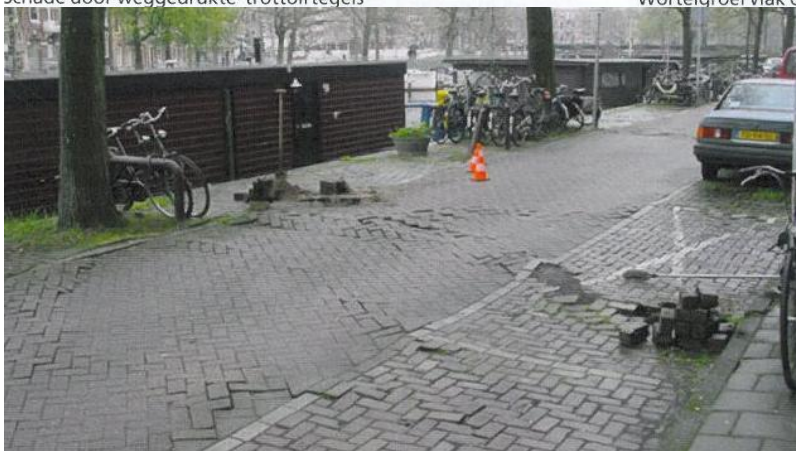
Schade door weggedrukte trottoirtegels
