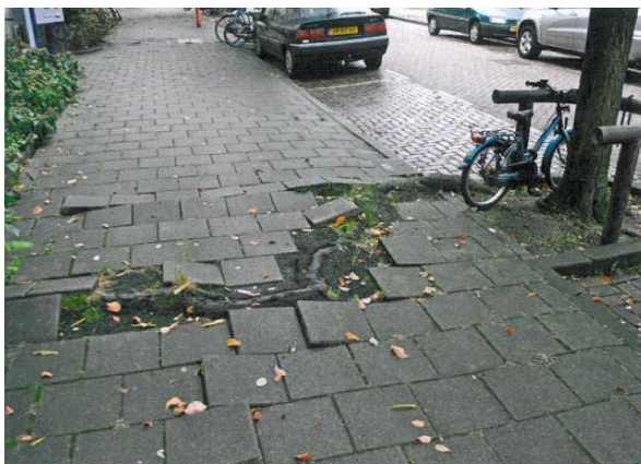
Schade door weggedrukte trottoirtegels
