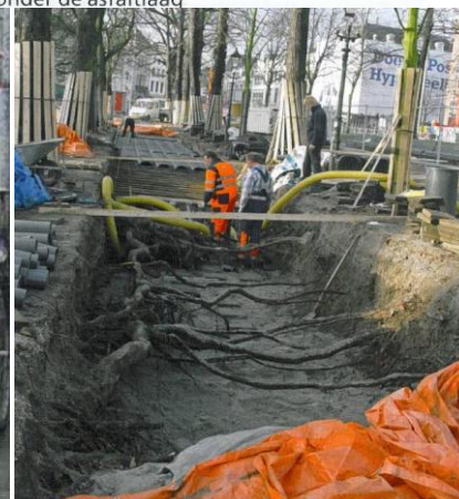
Wortelgroei vlak onder de asfaltlaag
