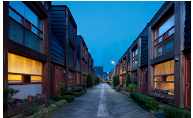
Stellinghof Vijfhuizen (NL), Dokarchitecten
