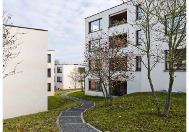
Zürich, Bünzli & Courvoisier Architekten
