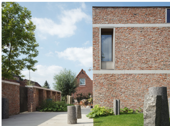
Mariakerke atelierwoning, RAAMWERK
