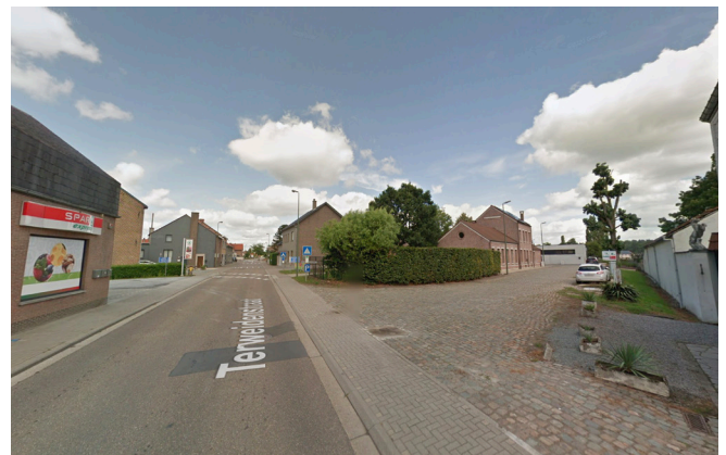
Oversteek van de IJzerenweg met voormalig station van Budingen (Google Streetview)
