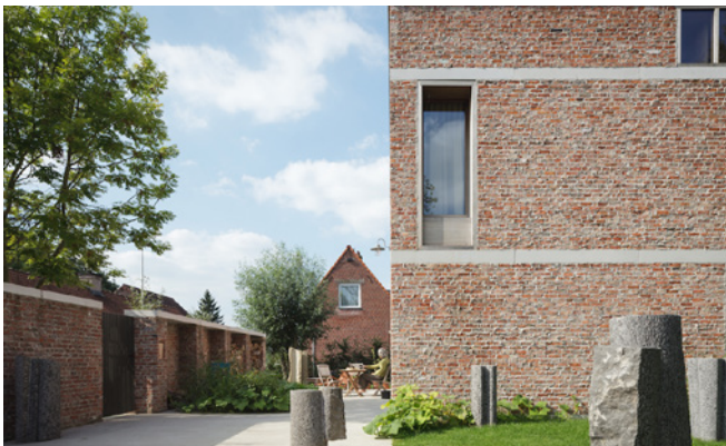
Mariakerke atelierwoning, RAAMWERK
