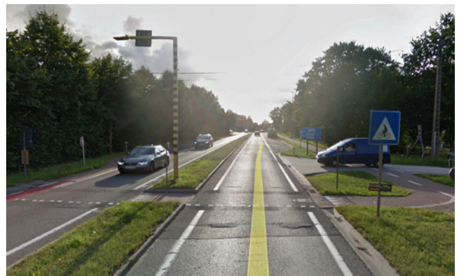
Oversteekplaats met wachteiland langs R25 in Aarschot (google streetview)
