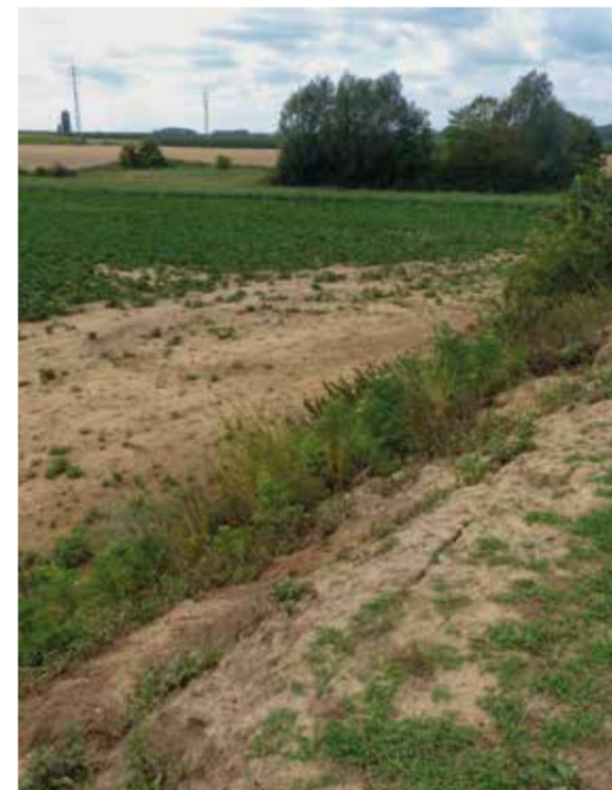
Erosie op een talud, die met aanplanten voorkomen kan worden.
