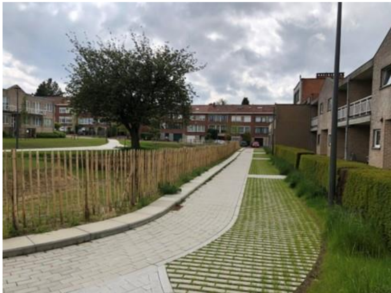
HERAANLEG KENNEDYPLEIN ZAVENTEM
