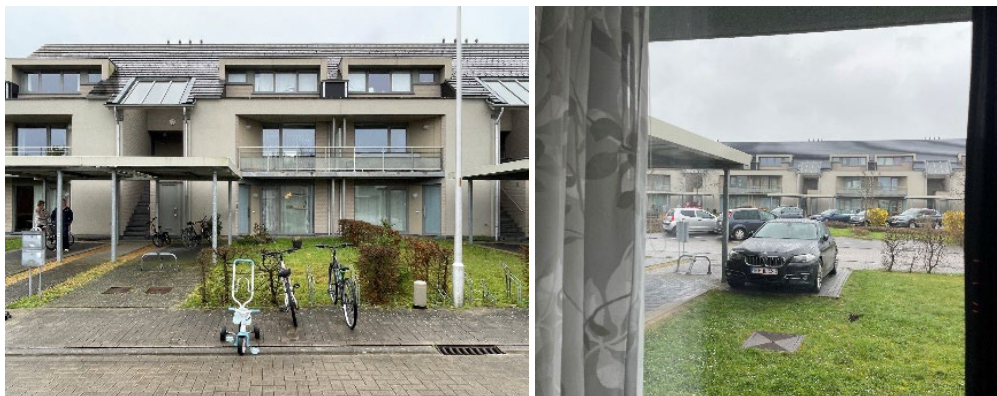
Blocksweide –inrichting publieke ruimte, zicht op de voortuin met parkeerplaats en de fietsenstalplaats
