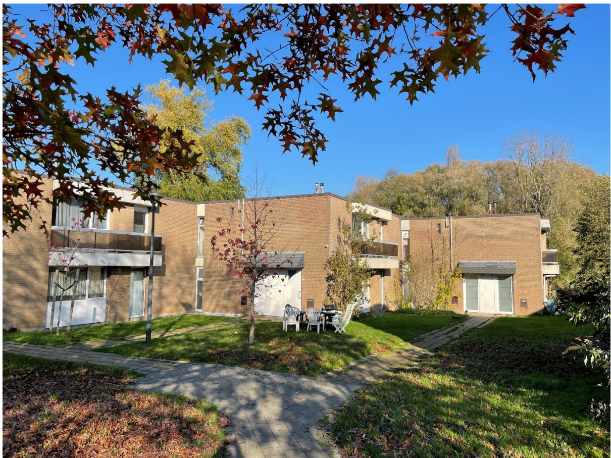
Oppem – Geschakelde woningen in de wijk
