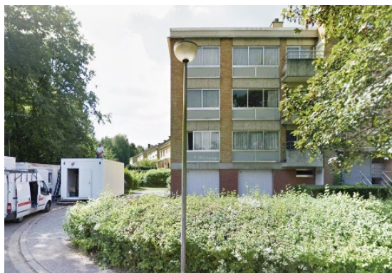
Sloesveld – zicht op de gevel van een niet gerenoveerd appartementsgebouw
