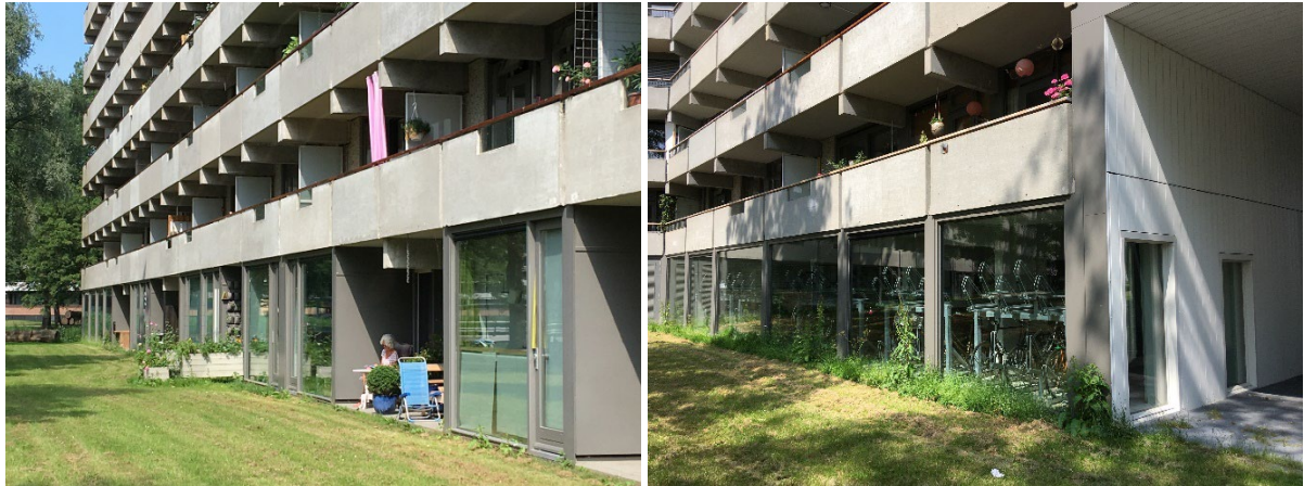
Keiburgflat - achtergevel en fietsenstalling
