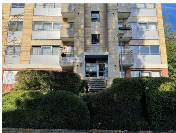
Sloesveld - huidige inrichting publieke ruimte: toegang tot woonblokken
