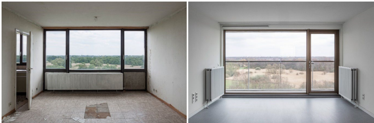
Rozemaai – interieur oud en gerenoveerd appartement Kempe Thill en RE-ST architecten (copyright: Ulrich Schwarz)
