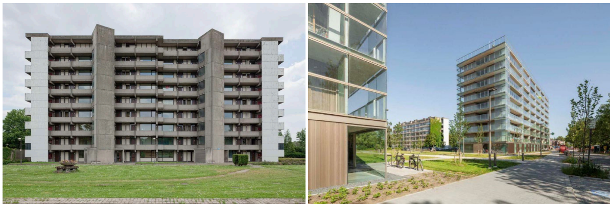
Rozemaai – oud en gerenoveerd appartementsgebouw Kempe Thill en RE-ST architecten (copyright: Ulrich Schwarz)
