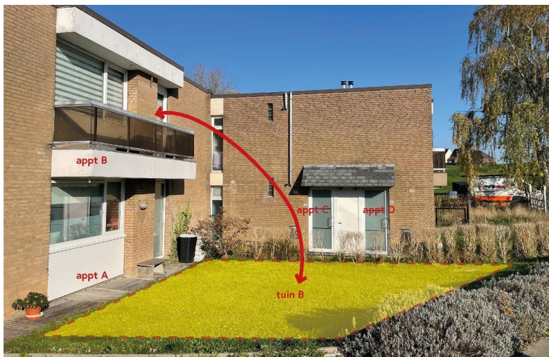
Oppem –tuin waar een privacy conflict aanwezig is tussen de appartementen op de 1e en 2e verdieping
